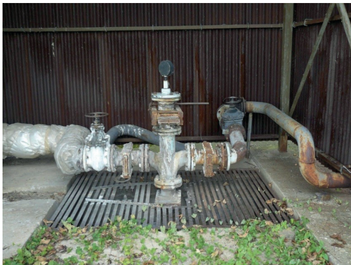
Obr. 7.9. Zhlavie jedného z najvýdatnejších geotermálnych vrtov Podunajskej roviny FGT-1 v Topoľníkoch (foto D. Marcin, 2010).
